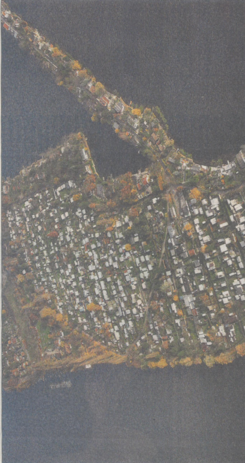
Ein Kanalschluss für jede einzelne Parzelle? Altrips Bürgermeister will dafür sorgen, dass kein Abwasser mehr vom Campinggebiet aus in den Neuhofener Altrhein (links) sickert.
